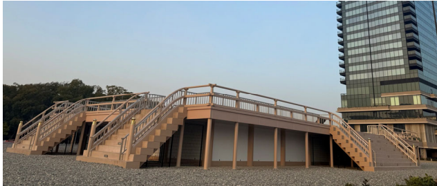
整備した後期内裏正殿
